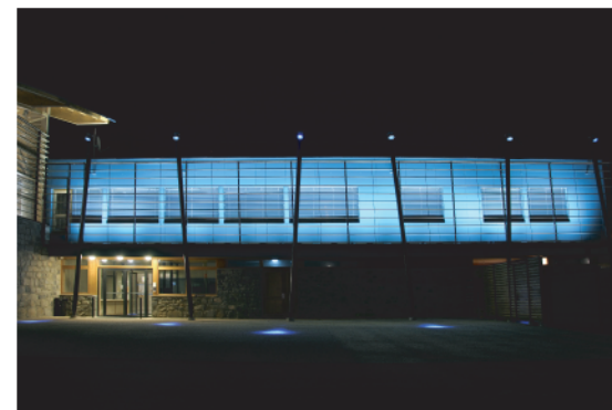
Façades du complexe sportif d'Yssingeaux Haute-Loire architecte D. Molard
