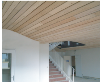
Créer un plafond courbe pour gommer les poutres béton sans diminuer la hauteur sous plafonds
