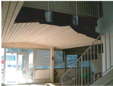
Créer un plafond courbe pour gommer les poutres béton sans diminuer la hauteur sous plafonds
